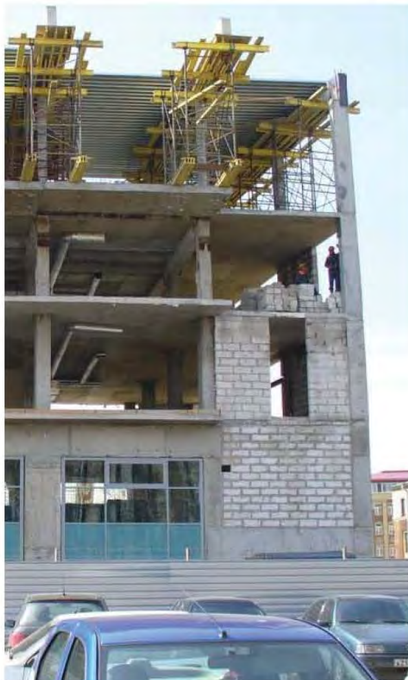
Рис. 9.3. Завершение кладки стены по оси «А» в зоне пересечения с осью «69»
