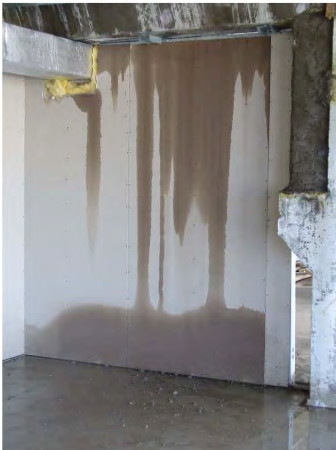
Рис. 10.1.Фрагмент намокших перегородок
