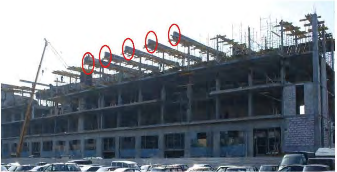
Рис. 1. Главный фасад здания. Выделены завершённые в полном объёме конструкции ригелей по состоянию на 27.04.05
