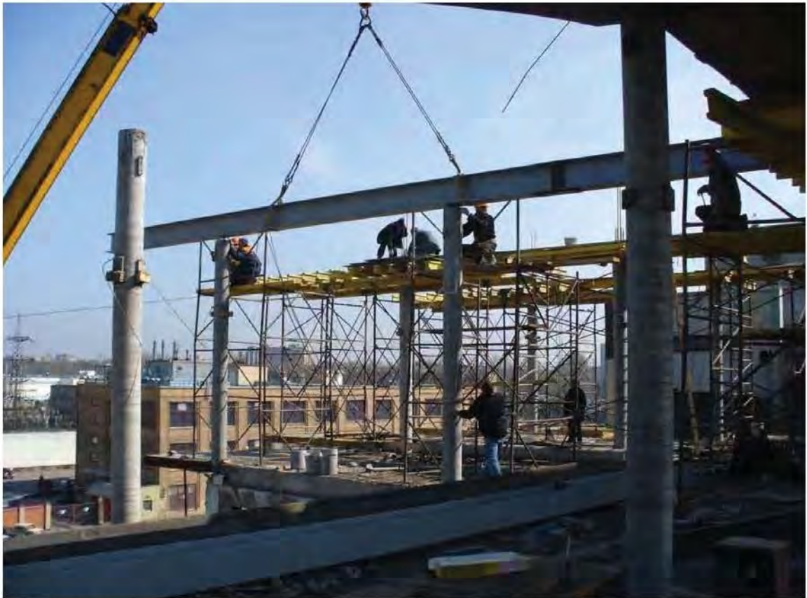
Рис. 3. Продолжение работ по монтажу несущих металлических конструкций атриума. 27.04.05
