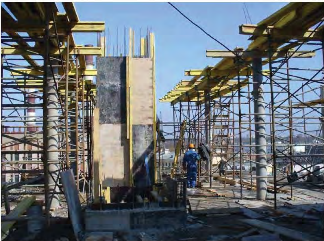
Рис. 4. Продолжение работ по возведению шахт лифтов № 1 и № 2. 27.04.05
