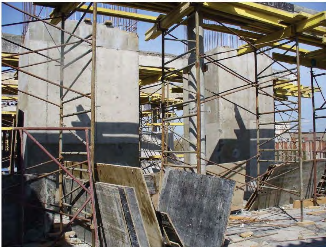
Рис. 8. Шахты лифтов № 1 и № 3. Возведены только монолитные железобетонные конструкции
