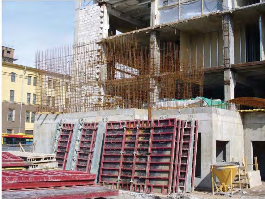
Рис. 6. Лестничная клетка № 1. Возведена только до отметки + 3.600
