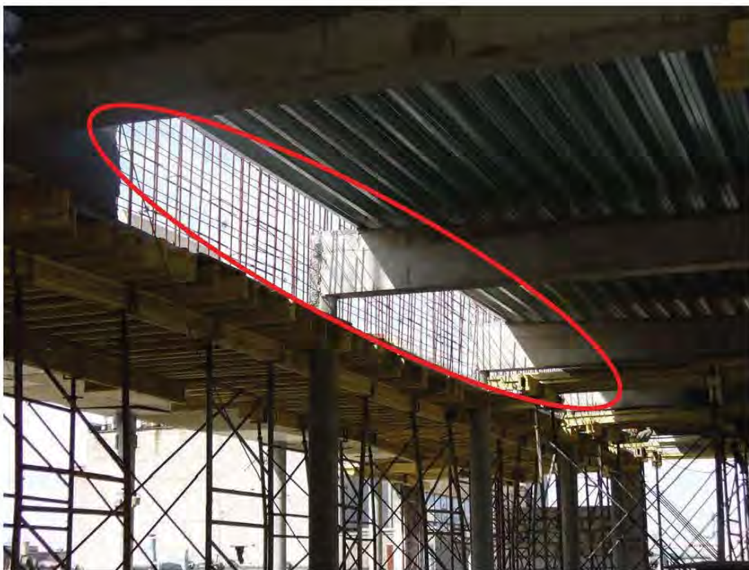
Рис. 5. Незавершенная часть монолитной стены технического этажа
