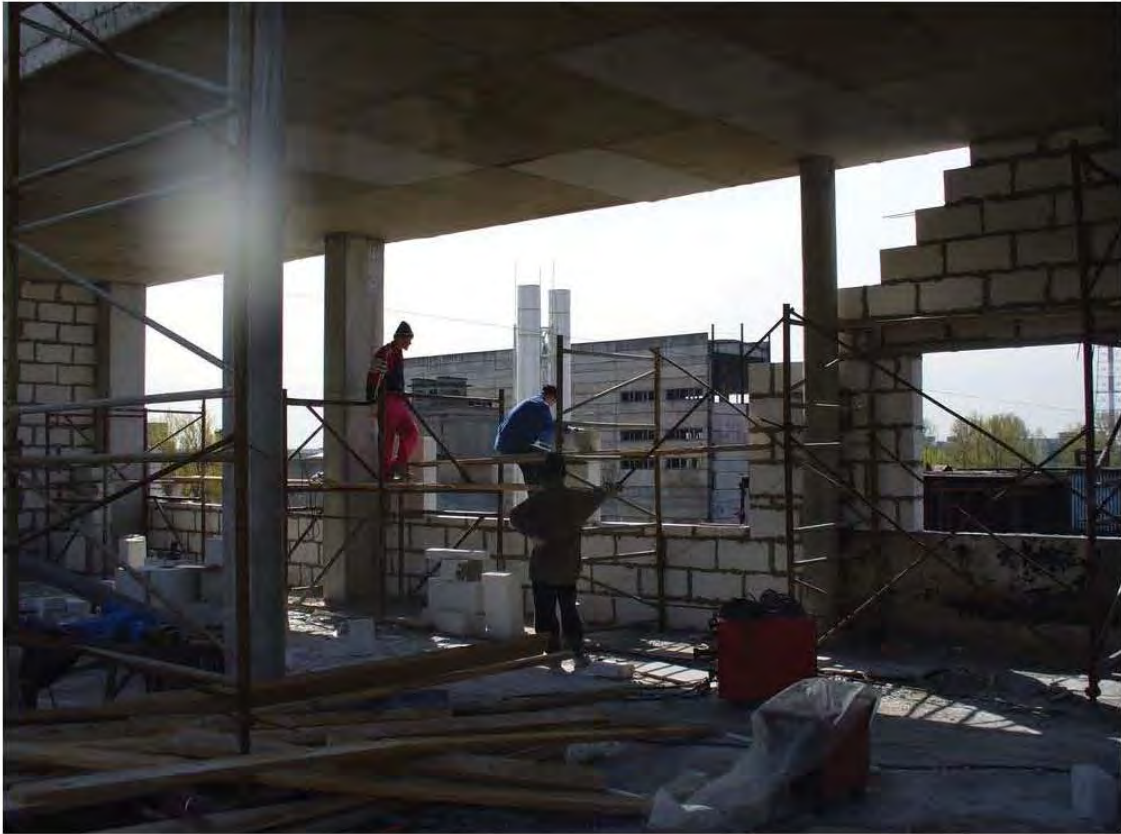
Рис. 9.2. Завершение кладки стены по оси «Г» в зоне пересечения с осью «53»
