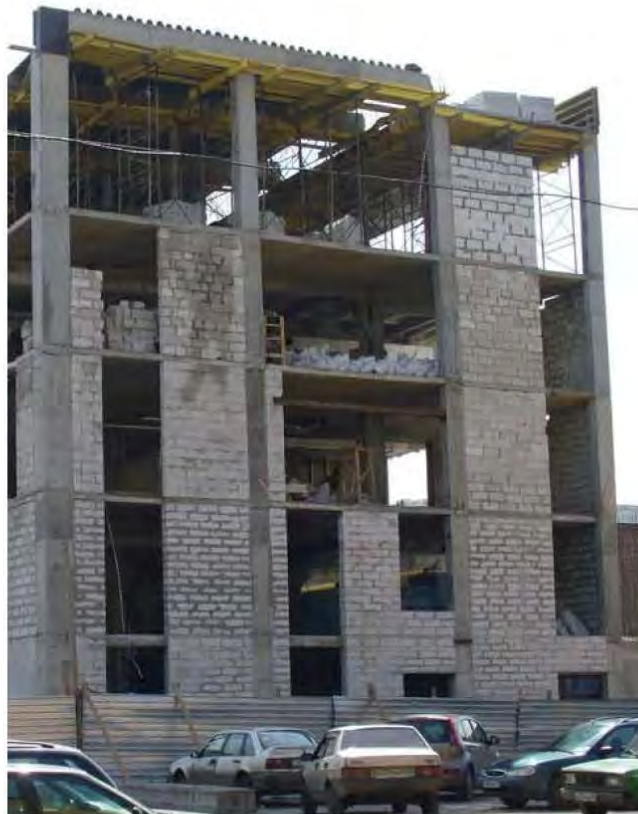
Рис. 12. Фасад со стороны Вазасского переулка
