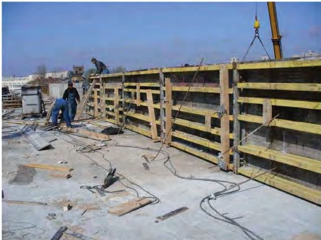
Рис. 2. Продолжение работ по возведению монолитных конструкций 5 этажа. 27.04.05
