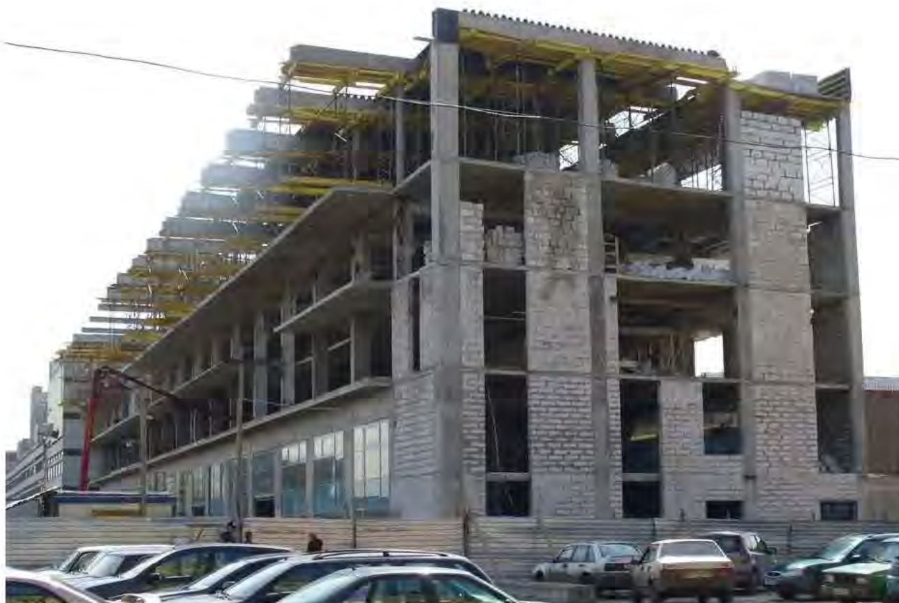
Рис. 13.2. Фасады корпуса. Оси «А» и «69». Состояние на 11.05.07
