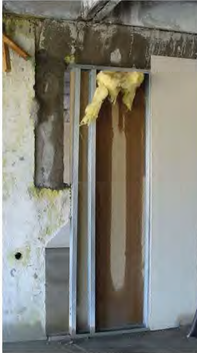
Рис. 10.3.Фрагмент намокших перегородок
