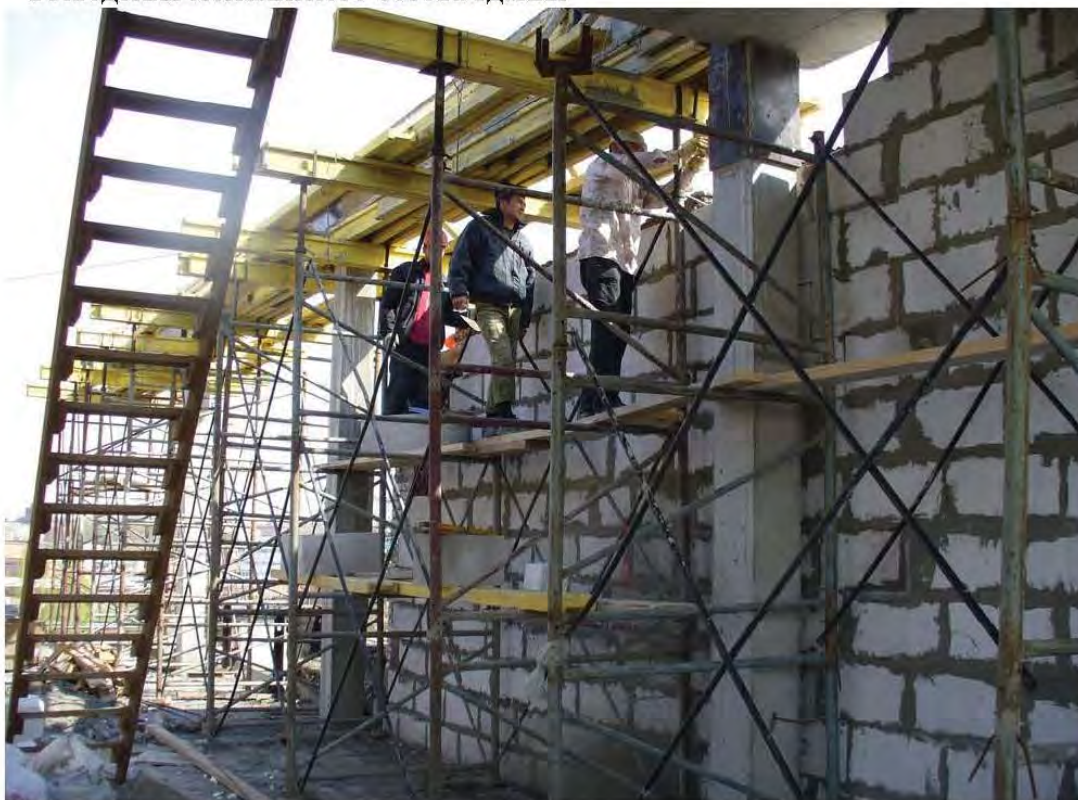
Рис. 9.1. Завершение кладки стены по оси 53 (брандмауэр)
