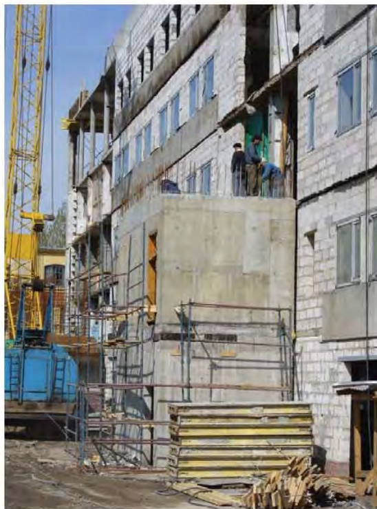
Рис. 7. Лестничная клетка № 2. Возведена только до отметки + 7.200
